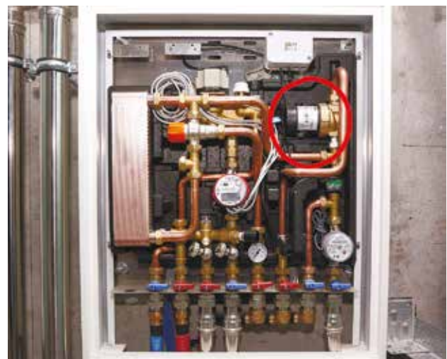
Рис. 9 Циркуляционный насос в квартирной станции с теплообменником VALTEC CONTOL SAT
