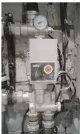
Рис. 9. Смесительный узел Solomix Uni-Fitt с клапаном MZ140-24B
