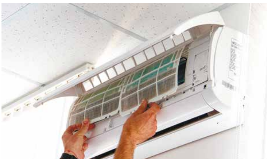
Рис. 1 Установка механического фильтра после его очистки
